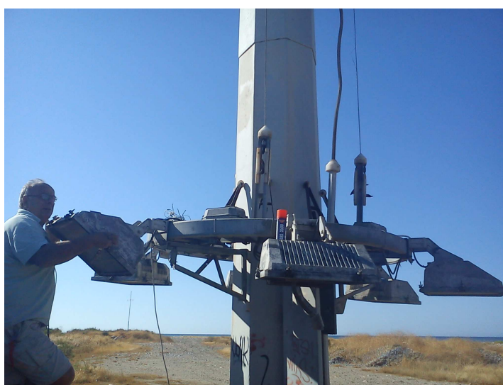
Εικόνες 3-4 : Υφιστάμενος ιστός φωτισμού ύψους 25μ και εκτέλεση εργασιών συντήρησης στους υφιστάμενους προβολείς συμβατικού τύπου (προς αντικατάσταση)
