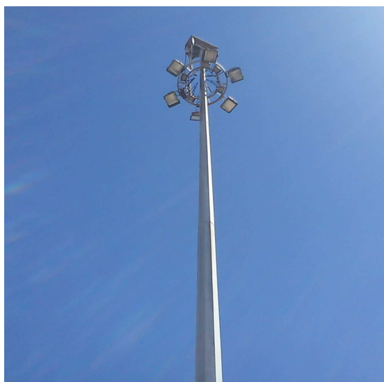
Εικόνες 3-4 : Υφιστάμενος ιστός φωτισμού ύψους 25μ και εκτέλεση εργασιών συντήρησης στους υφιστάμενους προβολείς συμβατικού τύπου (προς αντικατάσταση)
